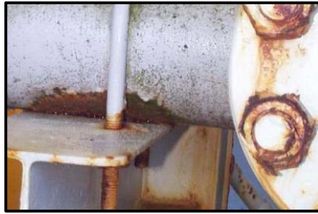
ภาพที่ 2 รูปภาพแสดงตัวอย่างการเกิดการผุกร่อนของระบบท่อที่ใช้โลหะต่างชนิดกัน
