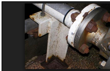
ภาพที่ 1 รูปภาพแสดงตัวอย่างการเกิดการผุกร่อนของระบบท่อที่ใช้โลหะต่างชนิดกัน
